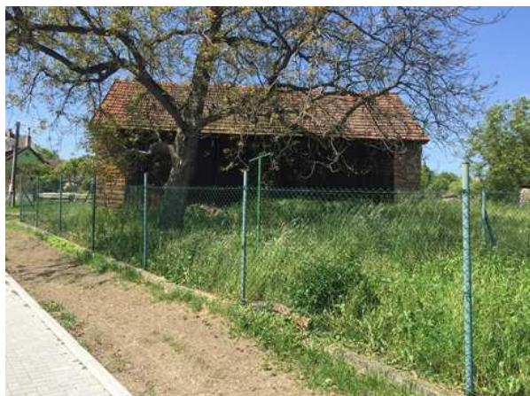
Stodola - pohled ze silnice
